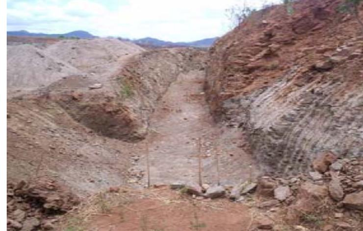
Vista da tomada d'água, onde se observa o seu desenvolvimento em curva, para o lado de montante, que foi concebido para que a mesma fosse assente em material com capacidade de carga suficiente para resistir aos esforços solicitados.
