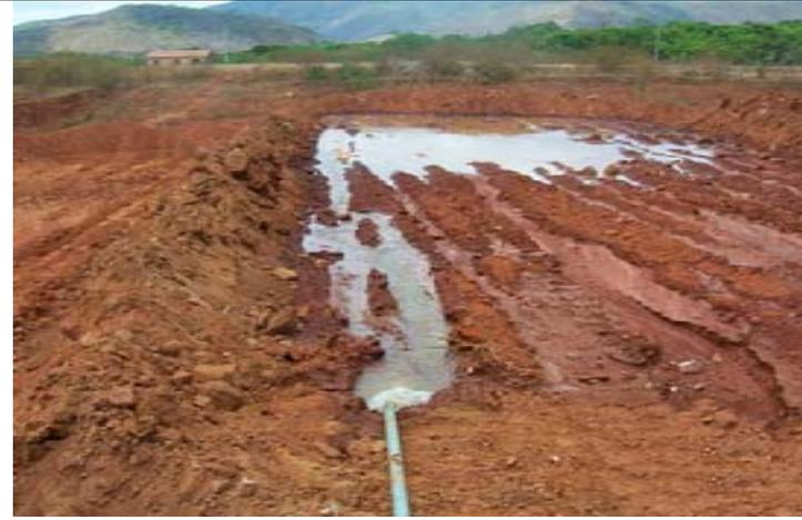
Detalhe do processo de umedecimento do material, a ser aplicado na execução do maciço, que vem sendo desenvolvido por inundação na área da própria jazida, localizada do lado de montante e do lado da ombreira direita.
