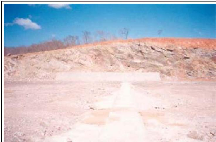
Foto 07 – Parede da cava, posicionada do lado direito do sangradouro, onde foi identificada a ocorrência de taludes negativos, que deverão ser totalmente removidos.
