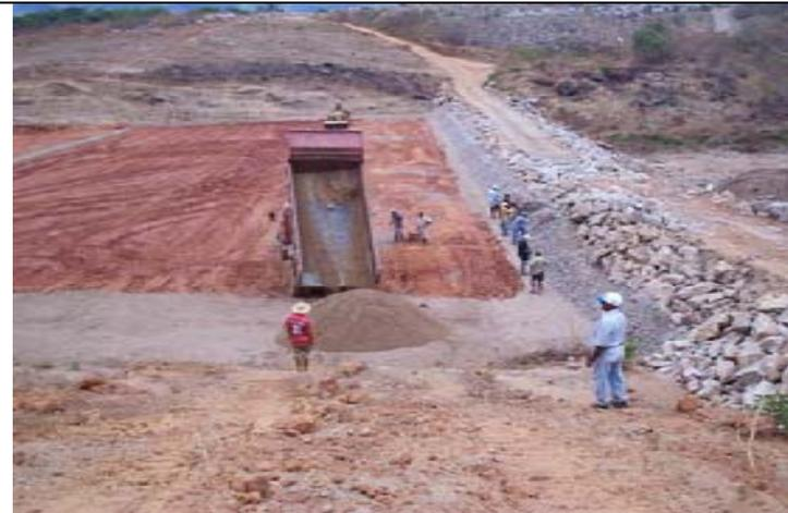
Etapa construtiva do filtro horizontal, caracterizada pelo lançamento de areia, que vem sendo executado com o basculamento direto da caçamba sobre as áreas de construção deste.
