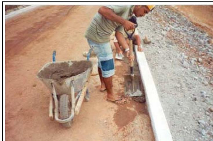
Foto 04 – Recomposição do revestimento primário do coroamento da barragem, próximo ao meio-fio, com aplicação de argamassa de cimento e areia no traço 1:3.
