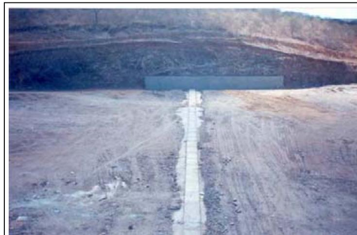
Foto 06 – Vista do cordão de fixação, executado no sangradouro.
