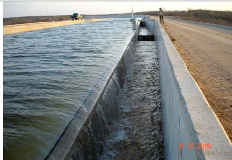
Canal transbordando pelos extravasores de uma das descargas de segurança, garantindo  $H_{max}=2,33m$
