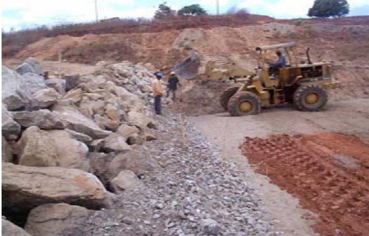
Lançamento de areia para a construção da transição do rock-fill, que vem sendo executado com a utilização de pá carregadeira.
