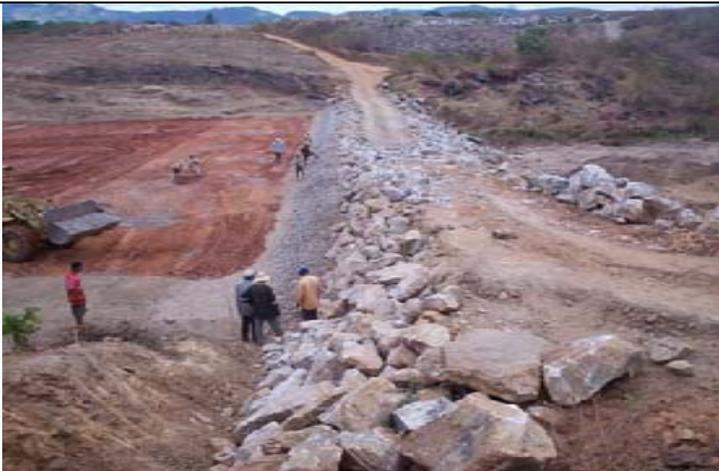
Registro do processo construtivo do rock-fill, onde podem ser observados a transição, executada com brita, e o enrocamento com pedras de diâmetros variados.
