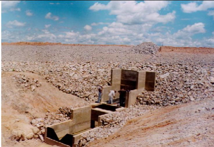
Tomada D'água - detalhe para complementação de enrocamento ao redor da caixa de jusante
