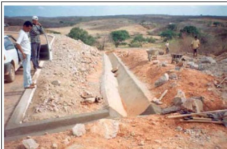
Foto 03 – Vista da drenagem superficial executada nas ombreiras da barragem, onde se observa a calha executada do lado da ombreira direita.
